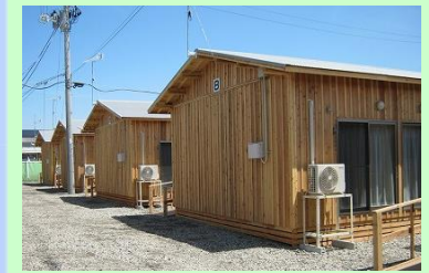
木造仮設住宅（設置例）
