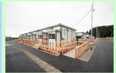
プレハブ住宅（設置例）
